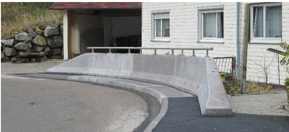
Abbildung 5: Fertige Konstruktion mit Betonleitwand
