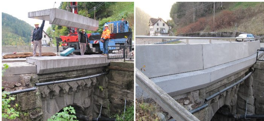
Abbildung 3: Versetzen der Kappen und fertige Konstruktion mit Betonleitwand
