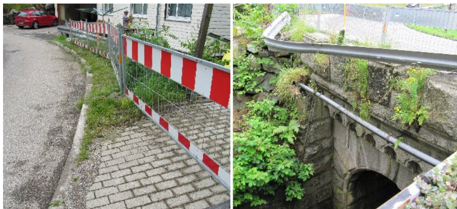
Abbildung 1: Zustand vor der Baumaßnahme
